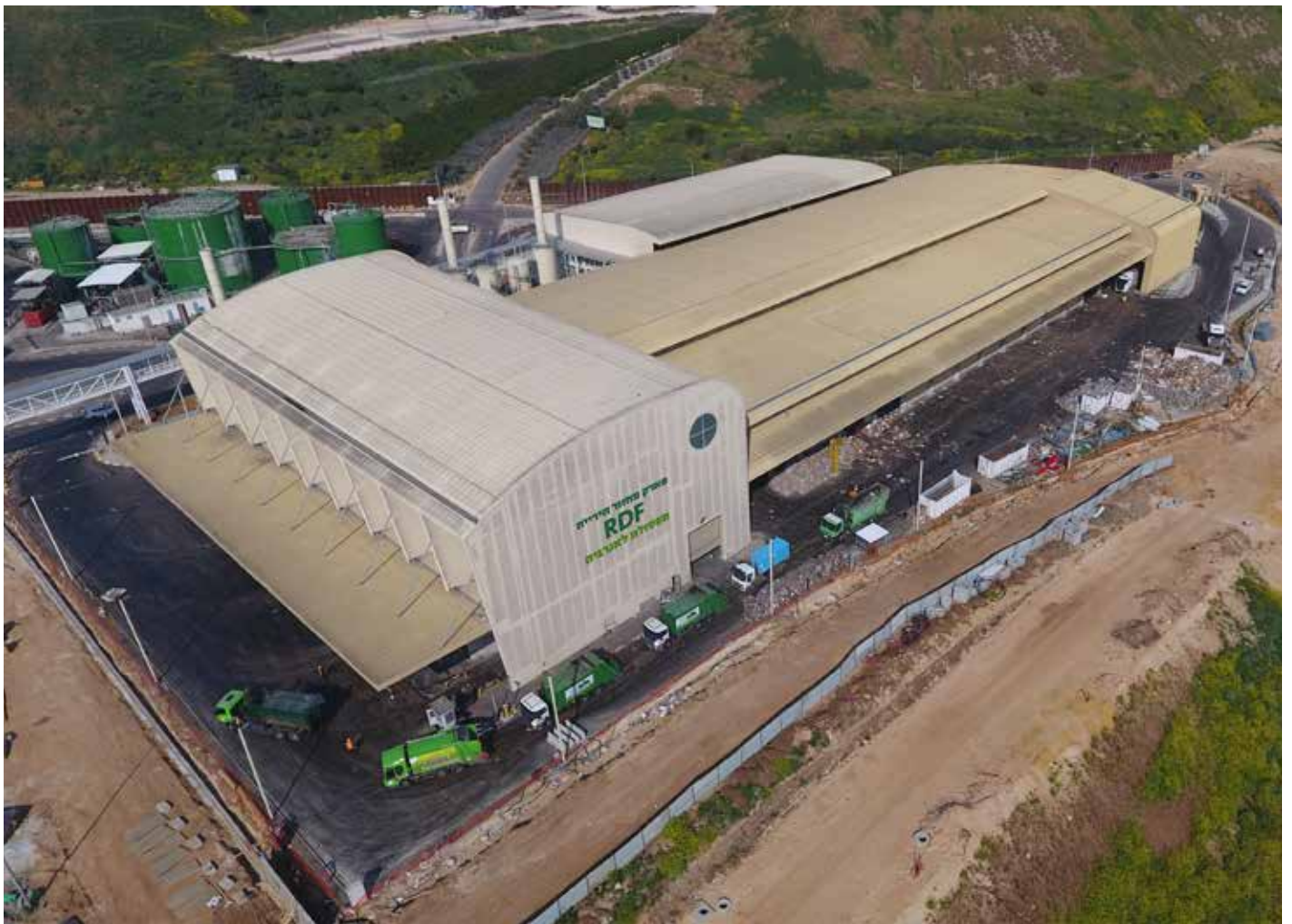
מפעל ה-RDF בחירייה, לייצור דלק מפסולת
